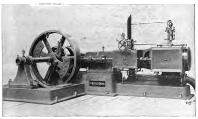
FIG. 105.-THE "RUSSELL' HIGH SPEED TANDEM COMPOUND ENGINE.
